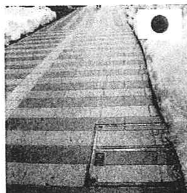
道路の雪を溶かす装置
