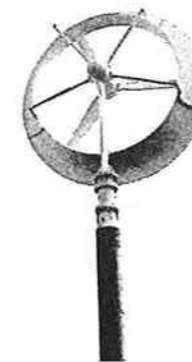
図4. 5 kW 風レンズ風車
